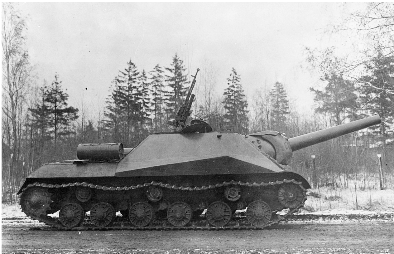
Силуэт ИСУ-152 обр.1945 года получился очень низким и сравнимым скорее с танком ИС-3, а не с самоходкой, вооружённой пушкой такого же калибра.
