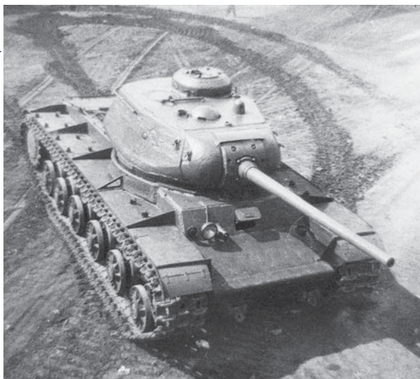
Объект 239 на заводском полигоне. Хорошо видно, как новая башня «накрывает» место на крыше корпуса, где раньше находился люк механика-водителя.
